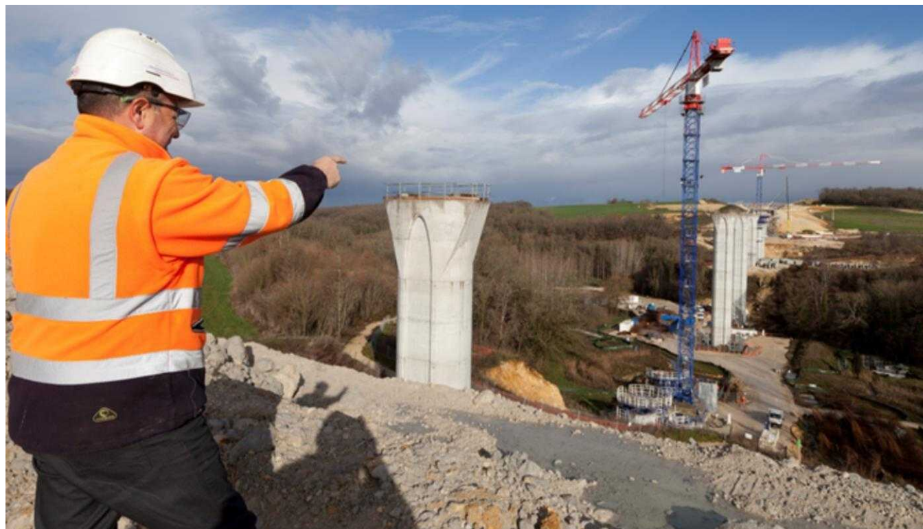
©crédit photo : Médiathèque Lafarge - Jean-Daniel Guilloux - LISEA
